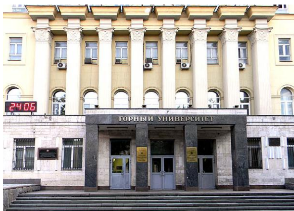
Рисунок 3. Корпус МГА. Современный вид здания
