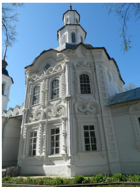
Рисунок 1. Церковь Иоанна Предтечи. Фрагмент южного фасада храма. Фото 2014 г.
