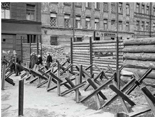
Рисунок 4 – Противотанковые заграждения
