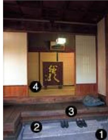
Рис. 4. Гэнкан (бетонный пол - татаки (1); каменная ступенька для обуви (2); деревянная ступенька - скидай (3); внутренняя прихожая - ёрицуки (4).
