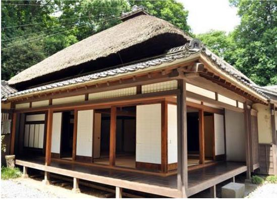
Рис. 3. Энгава - деревянная конструкция, аналогичная веранде
