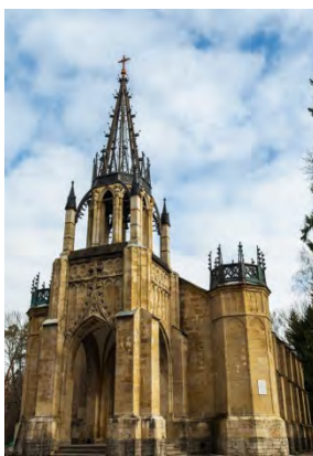
Рис. 4. Церковь святых апостолов Петра и Павла в Шуваловском парке Санкт-Петербурга, архитектор А.П. Брюллов (1837)
