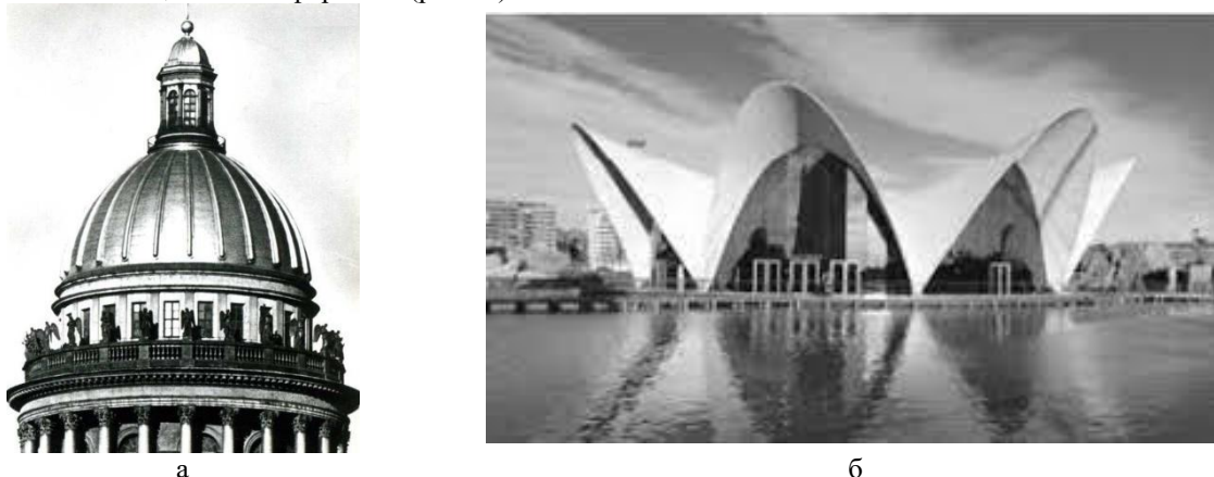
Рис.2. Параболические строительные конструкции в форме а – эллиптического параболоида; б – гиперболического параболоида.
