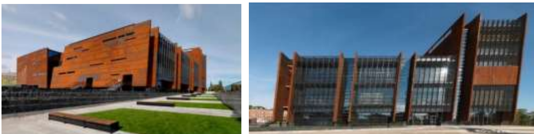
Рисунок 5. Южный и западный фасады ECS, покрытые кортеновскими плитами толщиной 5 мм.
